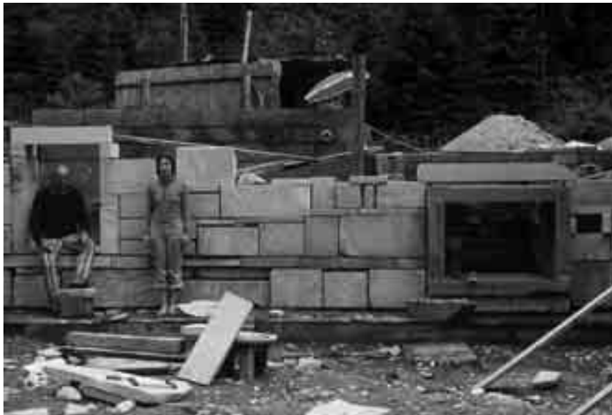
6. „Künstler bauen ihr Haus“, Krastal 1974 von li. n. re.: Heliane Wiesauer-Reiterer, Peter Rannacher und Otto Eder auf der Baustelle
